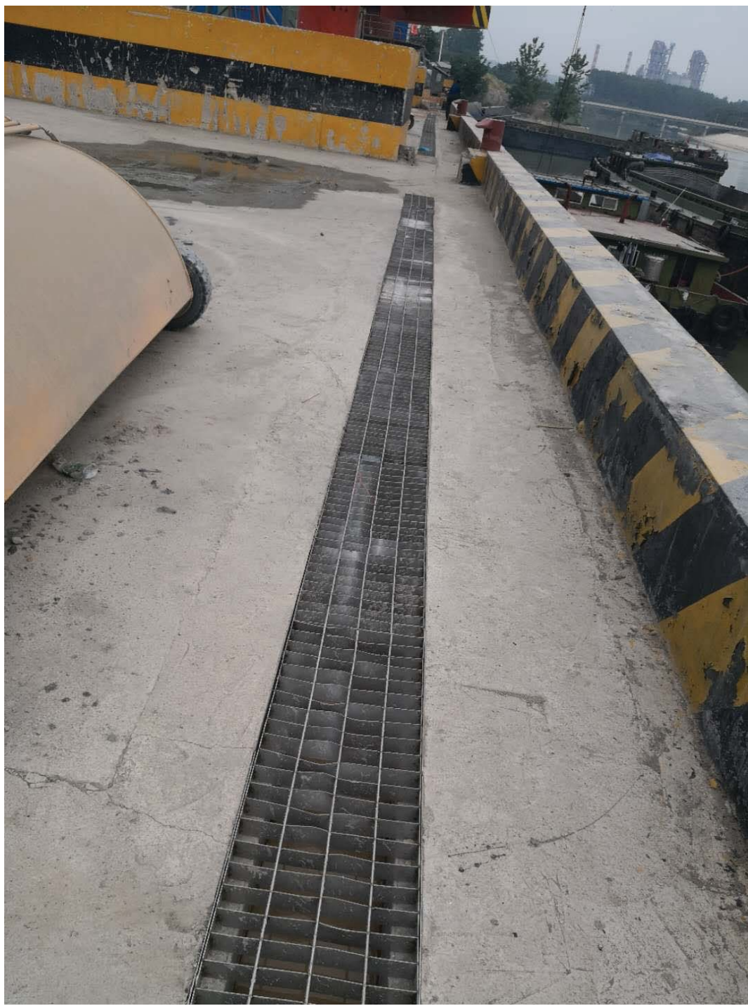
A 码头区排水沟（2019 年 12 月）
