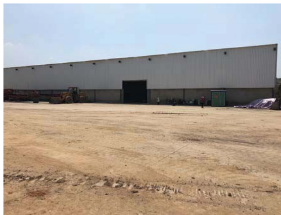
仓储区施工前
