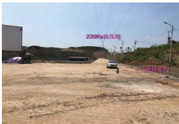
道路及绿化区施工前
