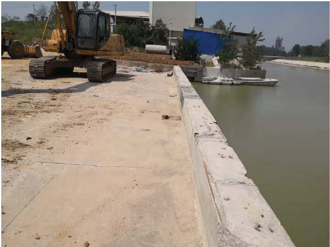
码头区施工中
