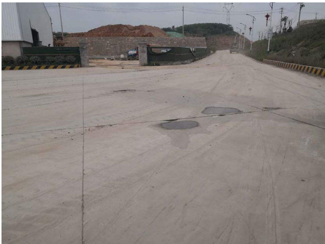
道路及绿化区施工后
