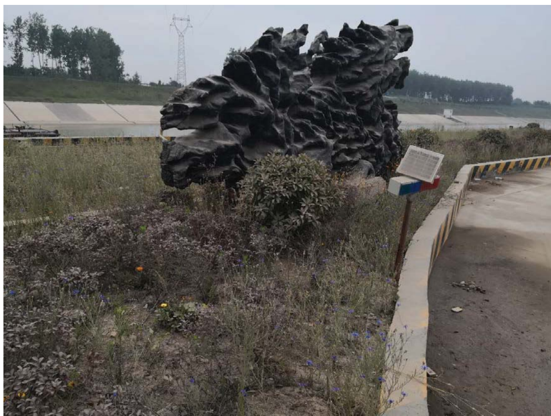
道路及绿化区施工后
