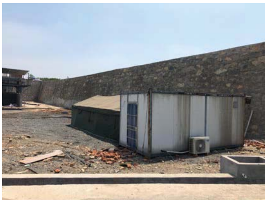
码头区施工前
