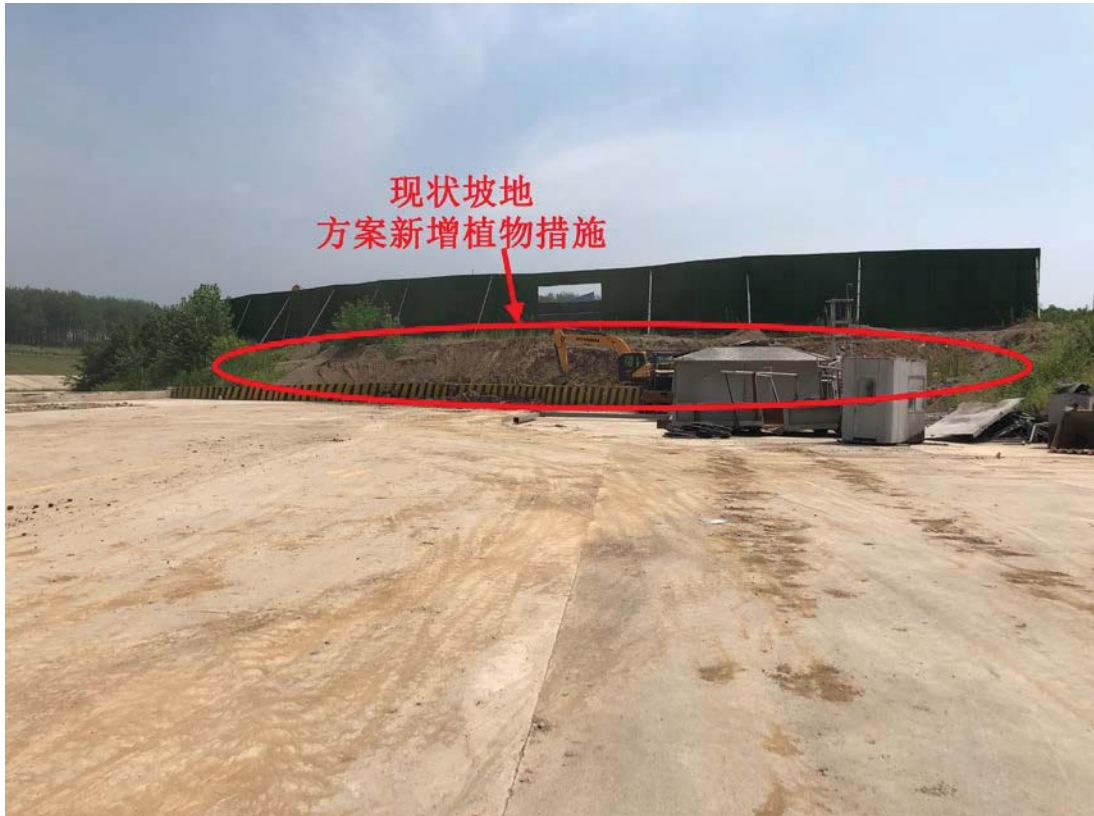
码头区施工中
