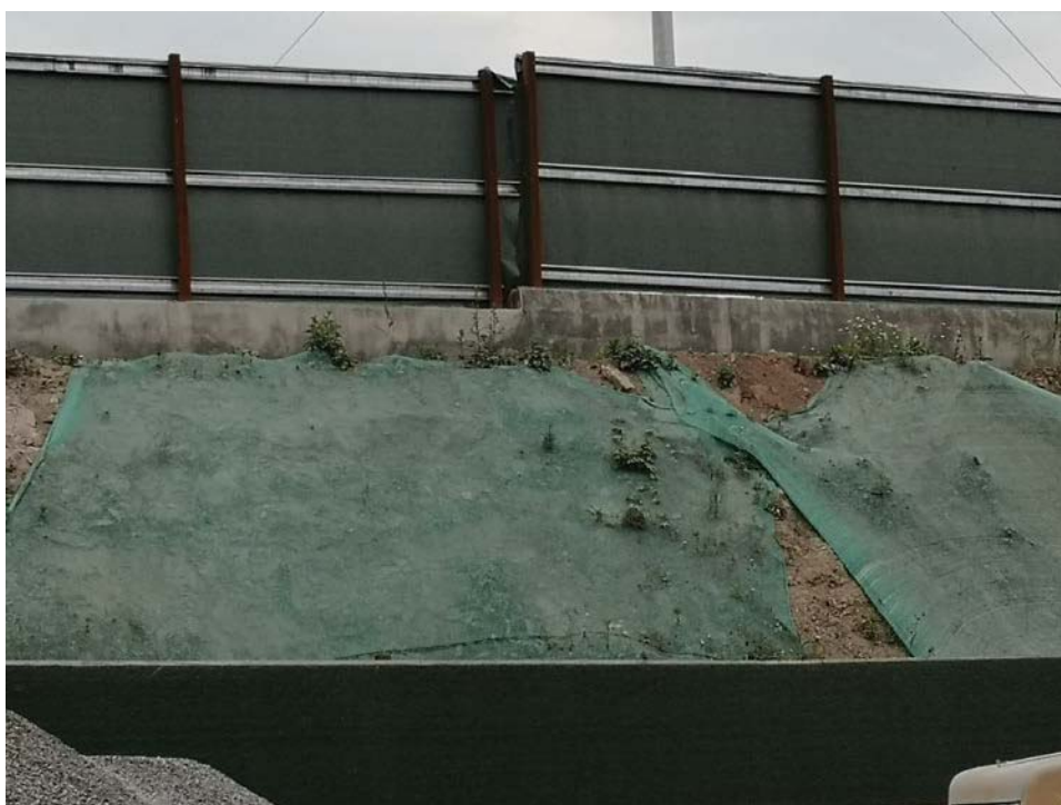
码头区施工后
