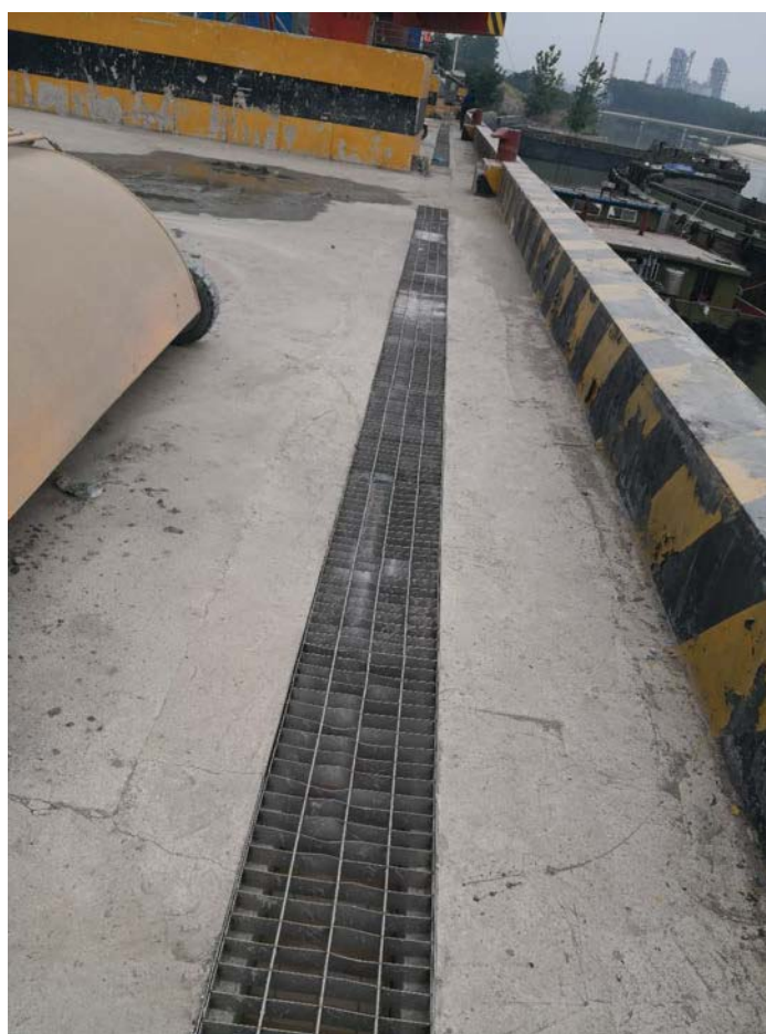
排水沟施工后
