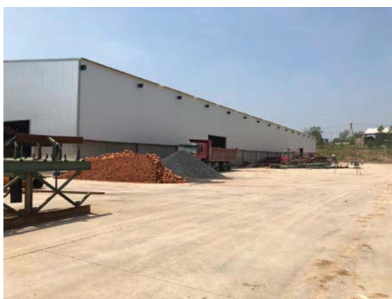
仓储区施工前
