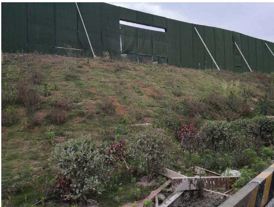
码头区施工后
